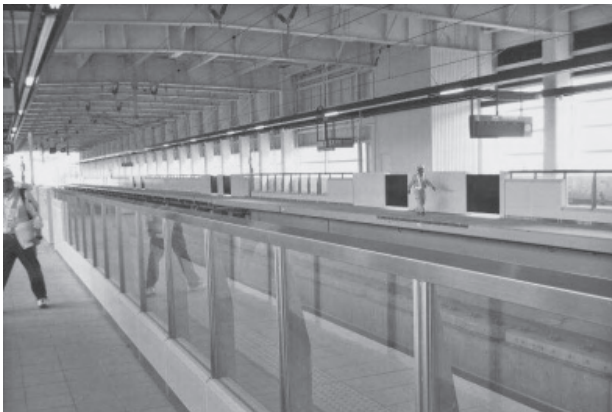
(上の写真) 3階新幹線ホームと駅の南側
