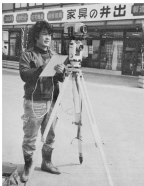
多角測量風景
