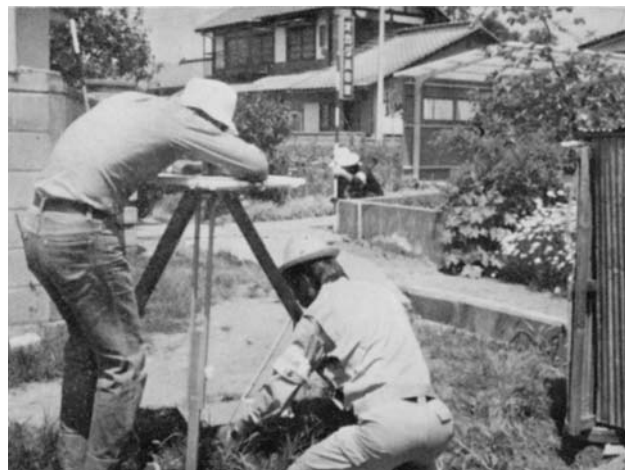
昭和55年頃の平板測量風景
